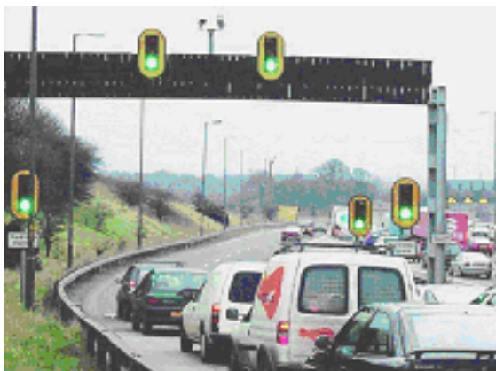
UK M6 Test Site
